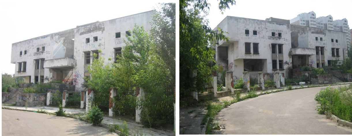
Рисунок 6-4. Внешний вид здания
