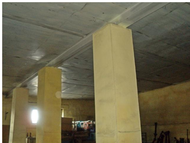
Фото 134 Здание склад с пристройкой (литер Л-1)
