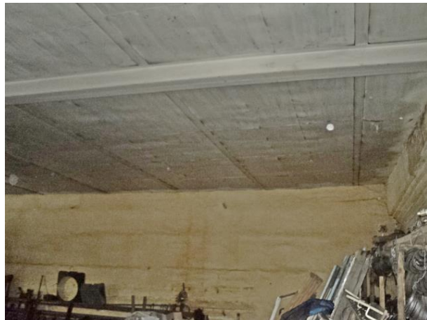
Фото 132 Здание – склад с пристройкой (литер Л-1)
