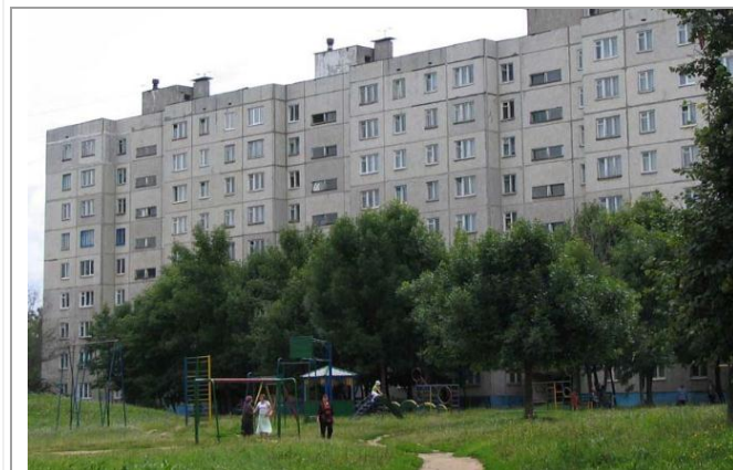
Внешний вид дома по ул. М. Павлова
