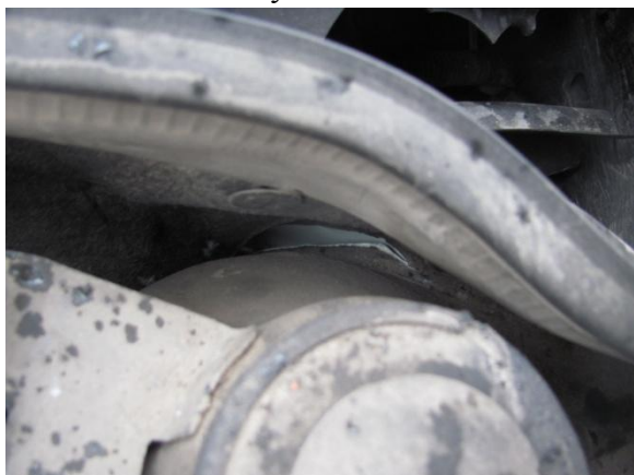
Фото №23 Нарушен шов арки и моторного щита
