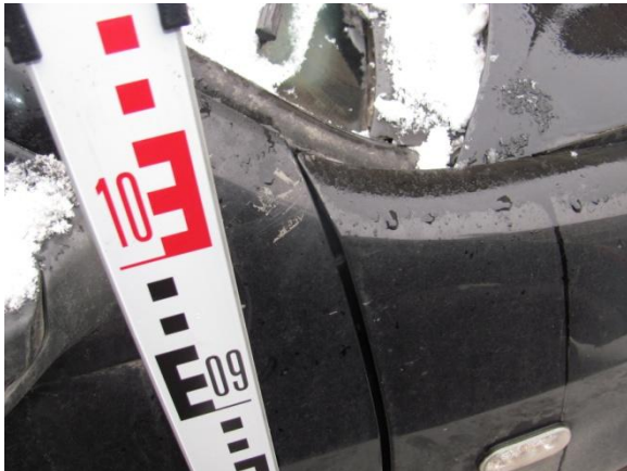
Фото №15 Нарушение зазора крыла прав.
